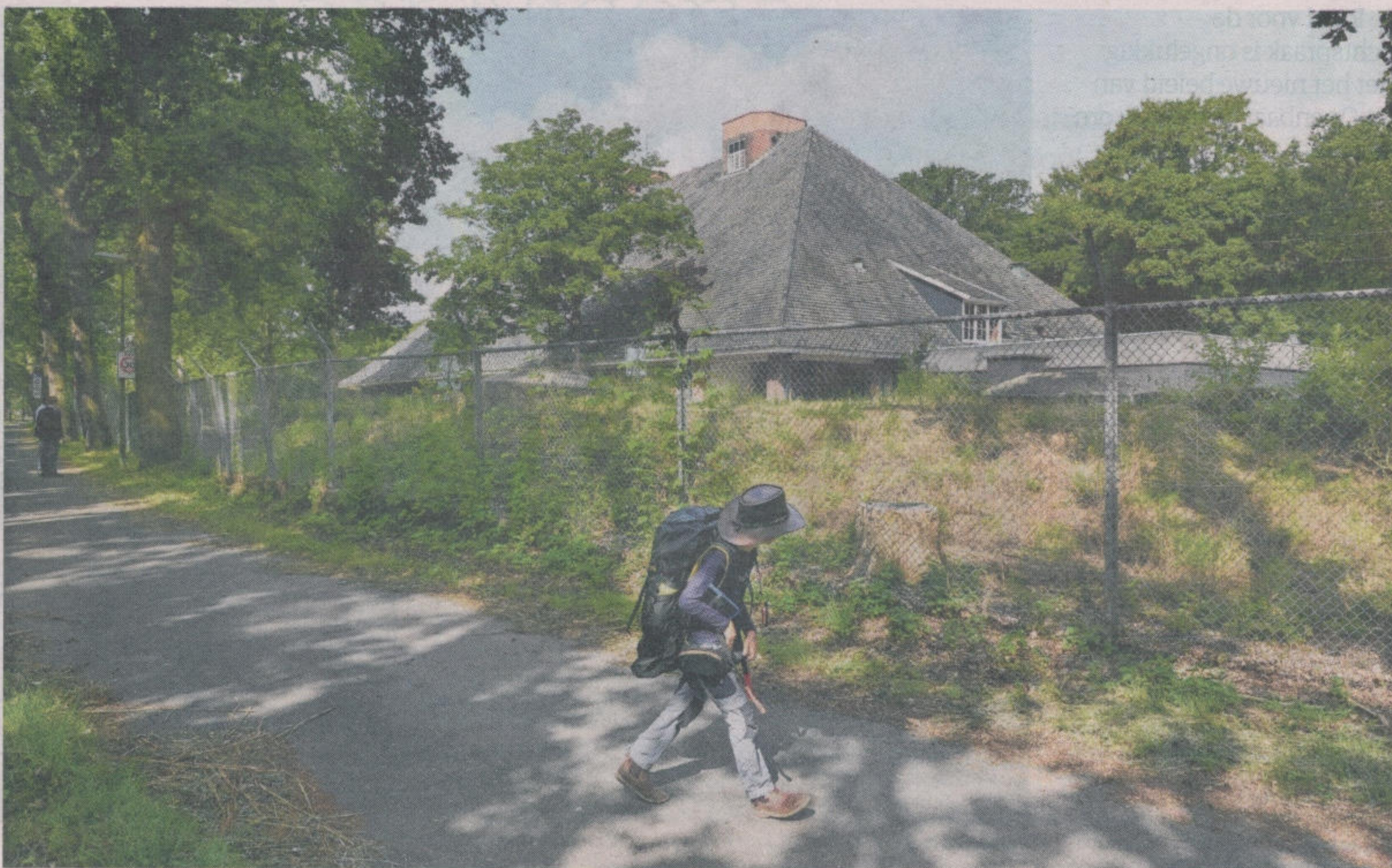
De commandobunker van Seyss-Inquart in Wassenaar. In maart begint de verkoop door het Rijksvastgoedbedrijf. FOTO PETER HILZ/ANP
