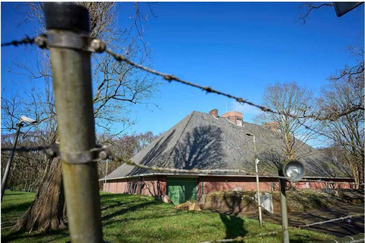
De Wassenaarse bunker werd gebouwd voor nazikopstuk Arthur Seyss-Inquart. Foto Phil Nijhuis
